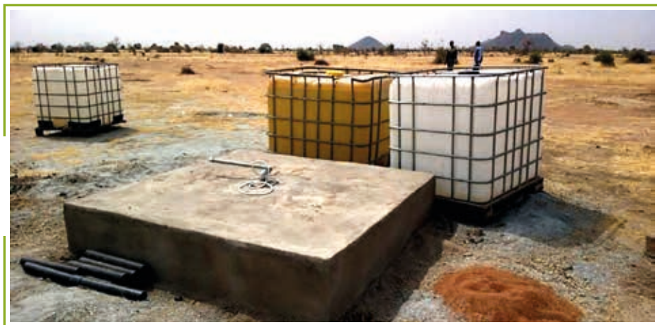
Plaque 31 : Ouvrage de pompage d'eau en cours d'implantation dans une plantation d'une grande superficie (Site Sahel Vert de Gawel I, 2016).
