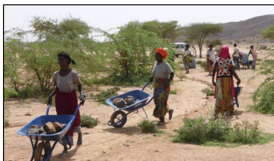
Foto links: Anlegen von Steinwällen zur Wasserrückhaltung (Gabionen), Gofat Est © GIZ
